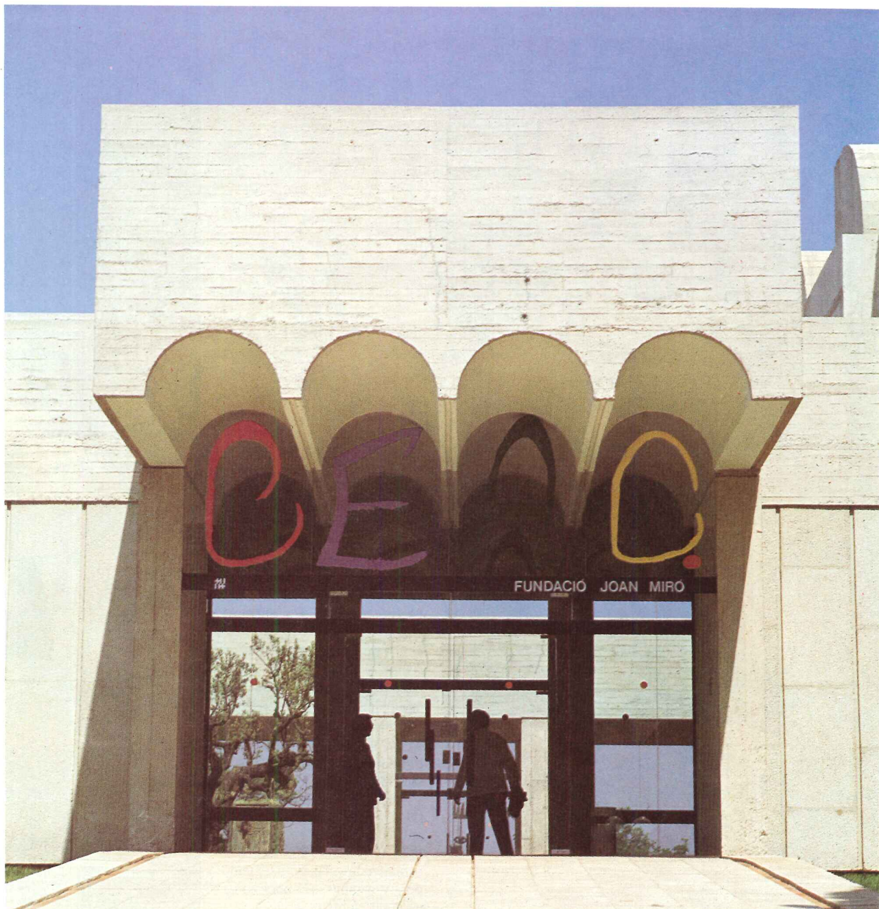
F. Catalá Roca photos
