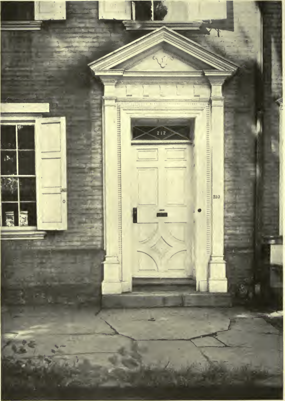
DOORWAY OF THE C. G. DON- NEL HOUSE, SUNBURY, PA., 1780.
